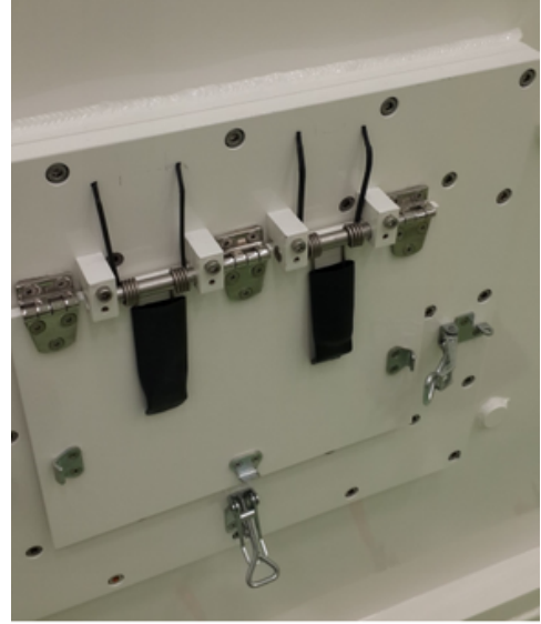
Acil basınç düşürme kapağı
